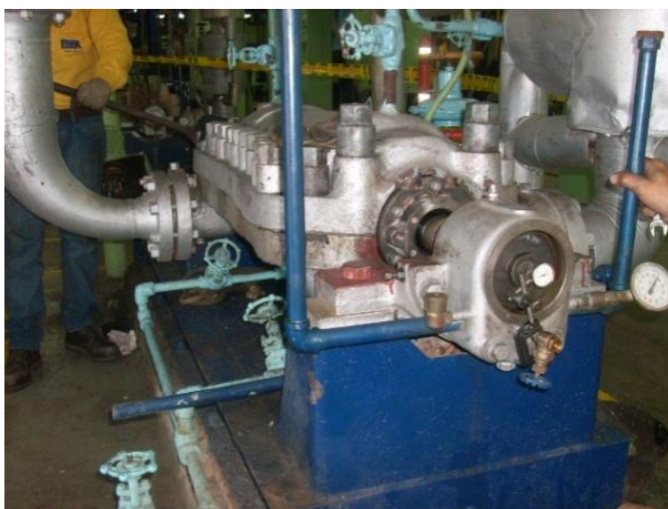
Desplazamiento axial de la bomba, instalación indicador de carátula – Bomba de alimentar caldera Unidades 1 y 2.
