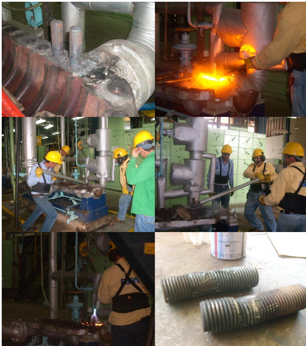
Espárragos dañados por deformación, maltrato en el roscado, soldadura – Bomba de alimentar caldera Unidades 1 y 2.
