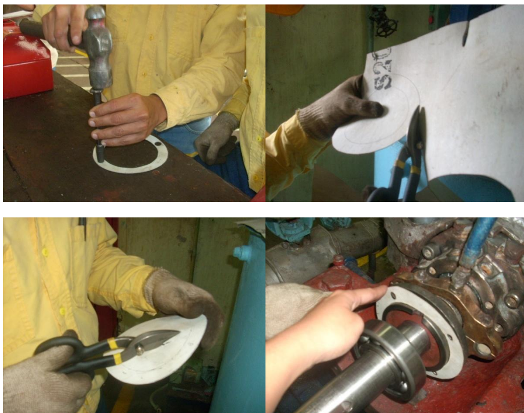
Sello de asbesto tapa chumacera – Bomba de alimentar caldera Unidades 1 y 2.
