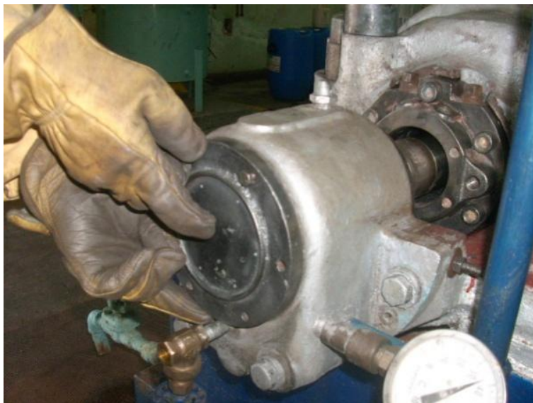
Instalación tapa ciega exterior de la caja de rodamientos, lado empuje – Bomba de alimentar caldera Unidades 1 y 2.
