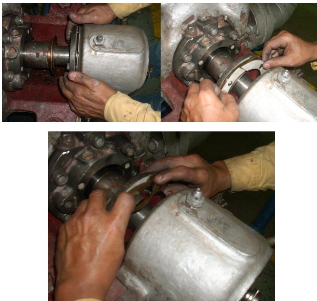
Desplazamiento axial de la bomba, instalación de shims lado empuje – Bomba de alimentar caldera Unidades 1 y 2.
