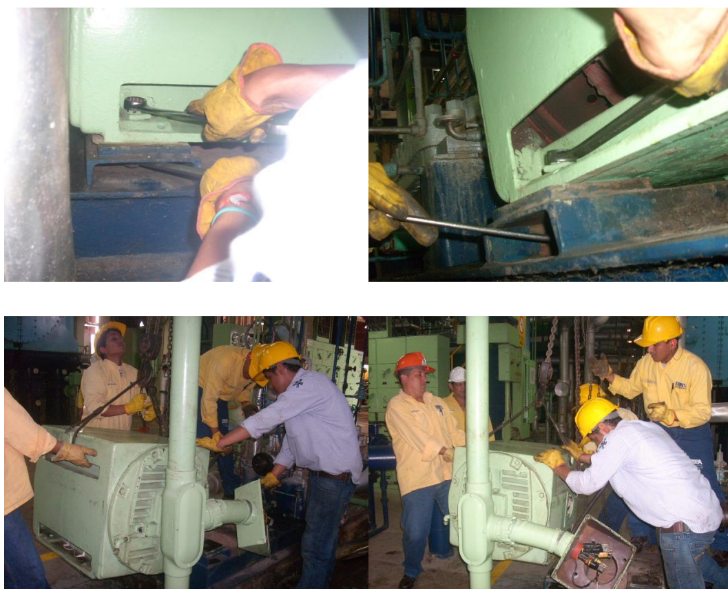
Montaje motor – Motor bomba de alimentar caldera unidades 1 y 2.
