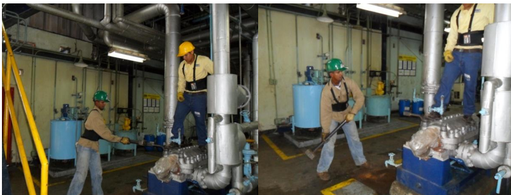
Apriete de las tuercas con porra – Bomba de alimentar caldera Unidades 1 y 2.
