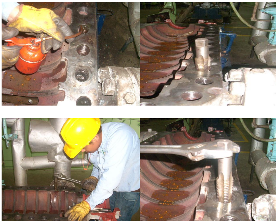
Limpieza con machuelo para definir roscado de la carcasa – Bomba de alimentar caldera Unidades 1 y 2.
