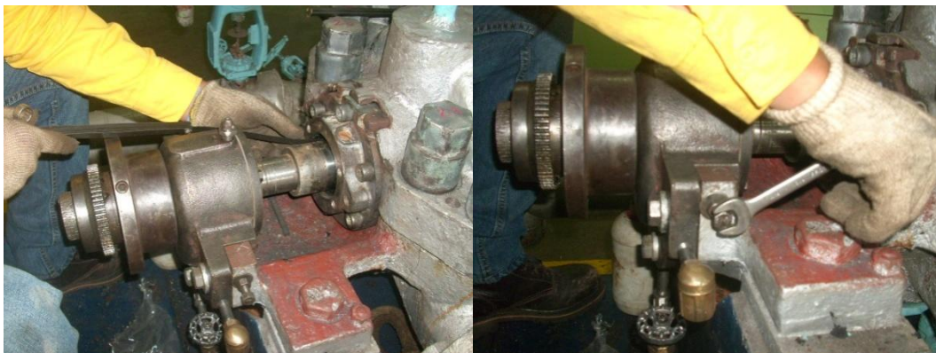
Centrado de la bomba lado acople – Bomba de alimentar caldera Unidades 1 y 2.
