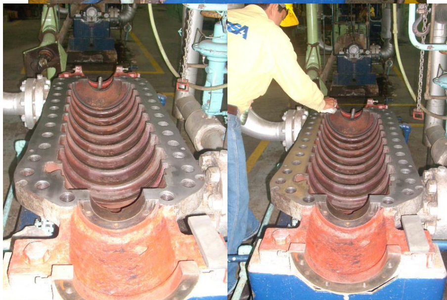
Limpieza y pulimento con piedra superficie tapa inferior del cuerpo de la bomba – Bomba de alimentar caldera Unidades 1 y 2.
