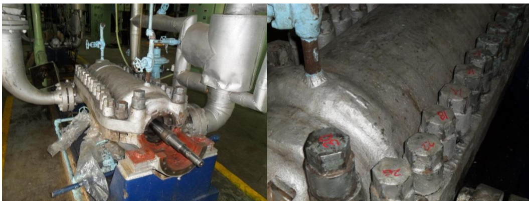
Cuerpo de la bomba instalado – Bomba de alimentar caldera Unidades 1 y 2.
