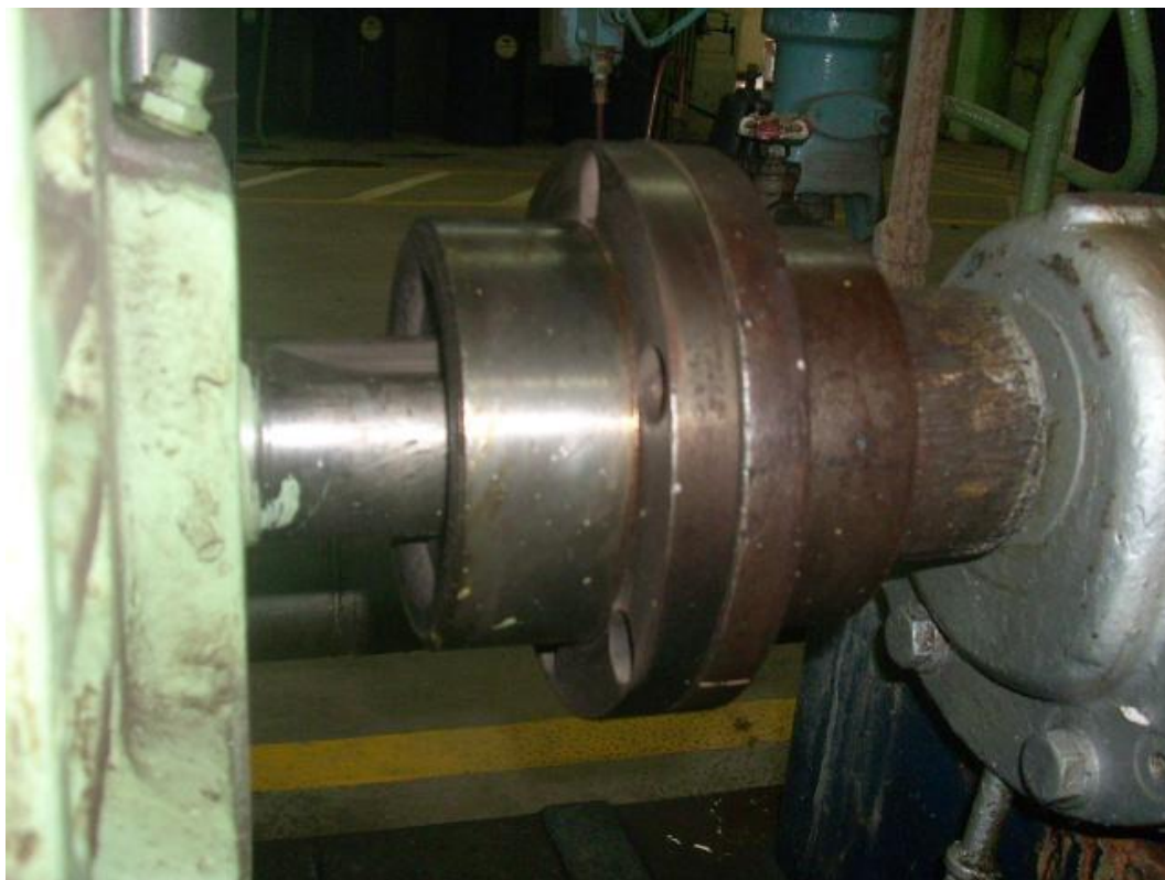
Acople rápido dentado – Motor bomba de alimentar caldera unidades 1 y 2.
