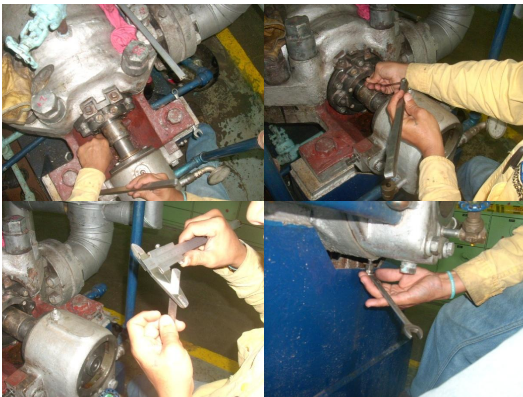
Centrado de la bomba lado empuje – Bomba de alimentar caldera Unidades 1 y 2.
