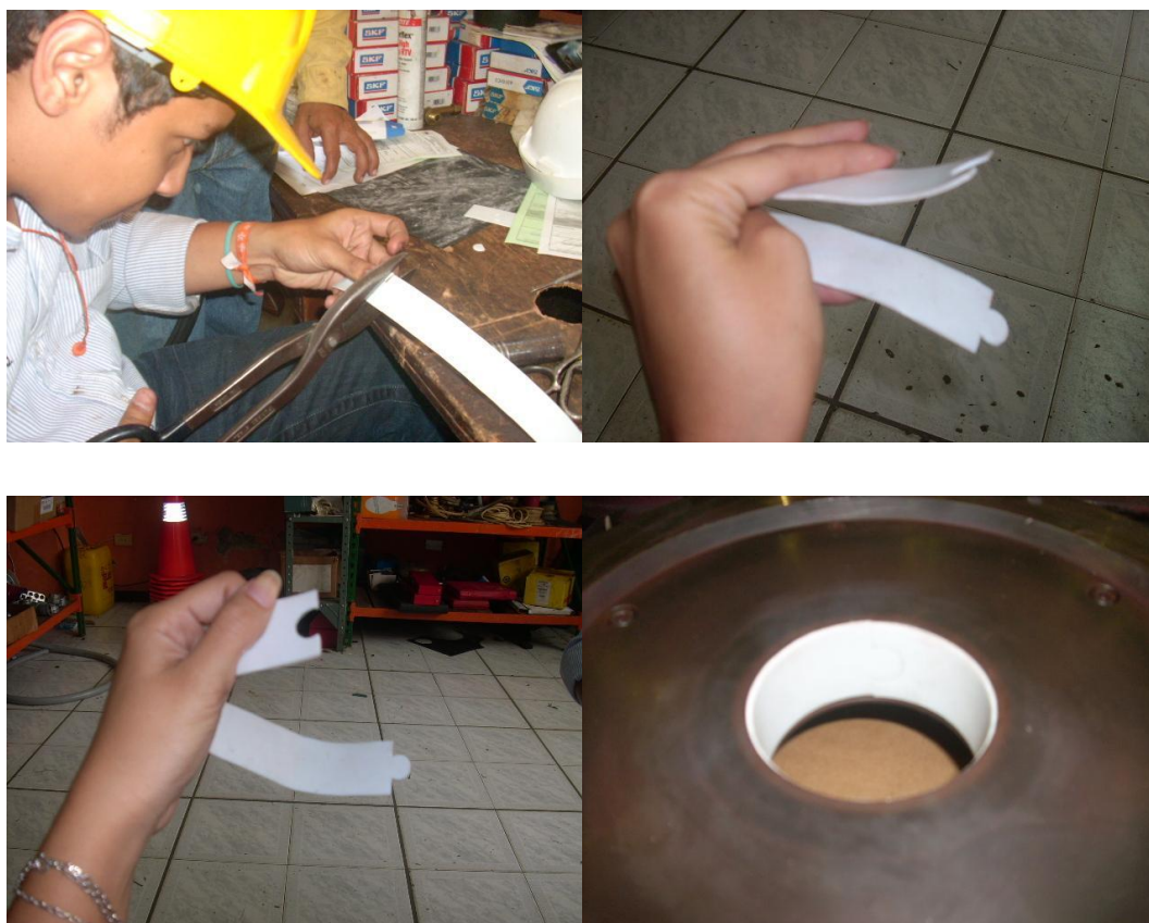
Cinta teflón para el canal del difusor – Bomba de alimentar caldera Unidades 1 y 2.
