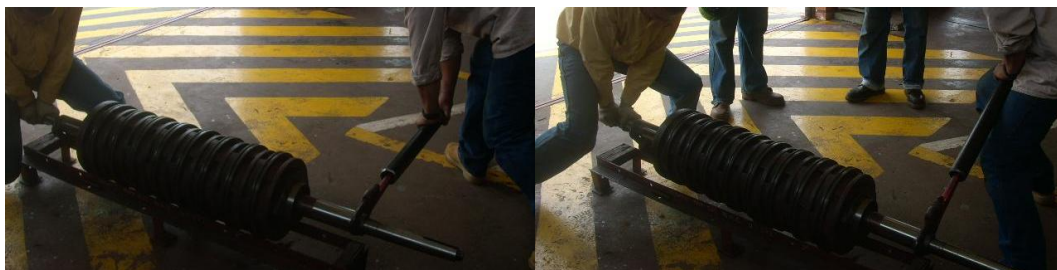
Apretando tuercas ajuste conjunto de piezas estáticas y móviles del eje – Bomba de alimentar caldera Unidades 1 y 2.
