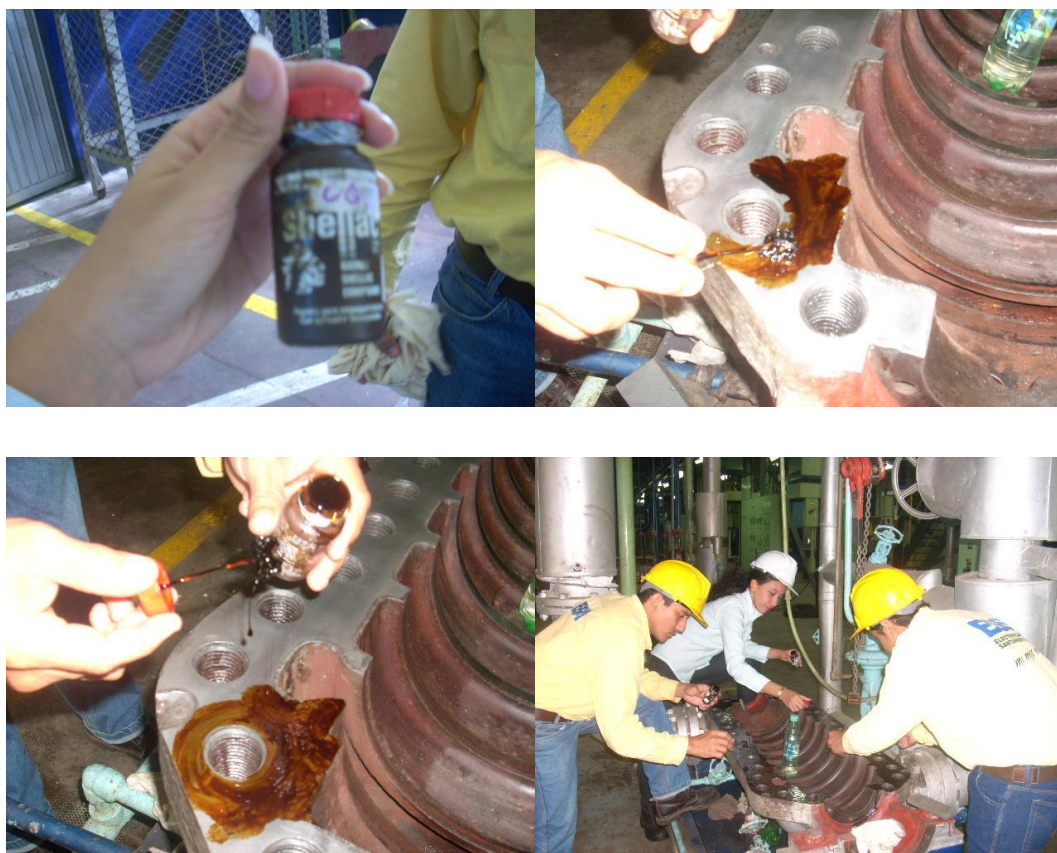
Pegante Shellac para el empaque de asbesto – Bomba de alimentar caldera Unidades 1 y 2.
