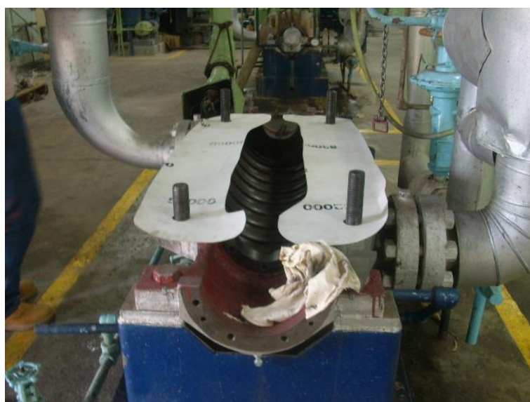
Empaque de asbesto instalado con 4 espárragos guía para la tapa superior – Bomba de alimentar caldera Unidades 1 y 2.
