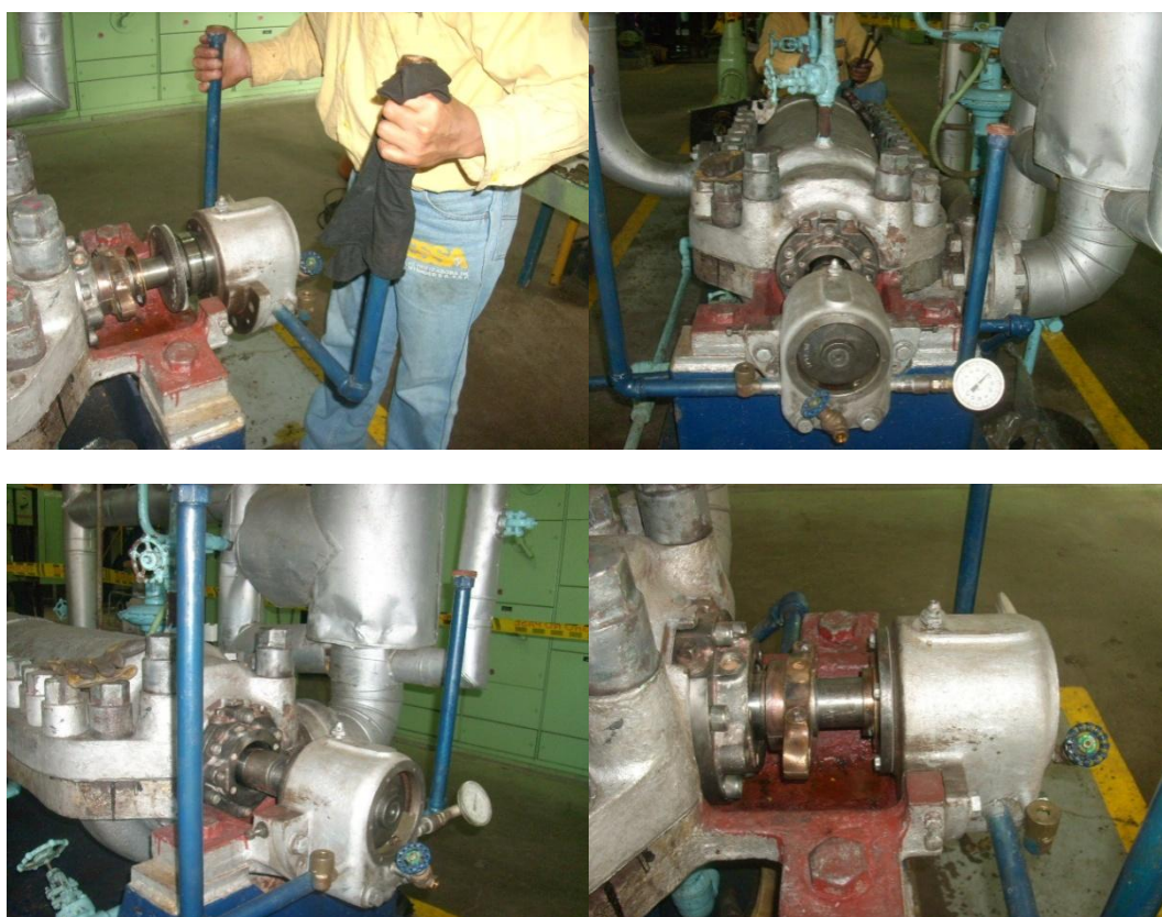
Instalación de la chumacera lado empuje – Bomba de alimentar caldera Unidades 1 y 2.
