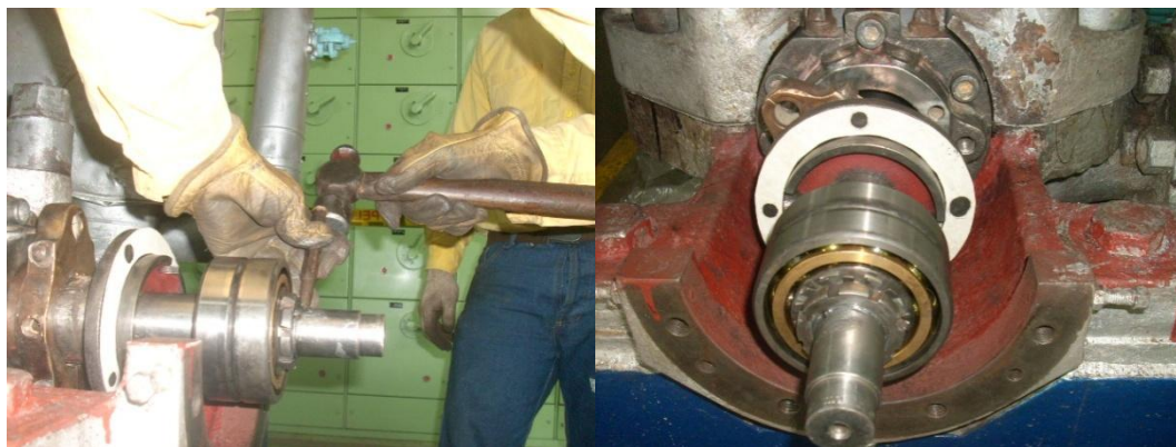
Apretar tuerca de seguridad a rodamientos lado empuje – Bomba de alimentar caldera Unidades 1 y 2.
